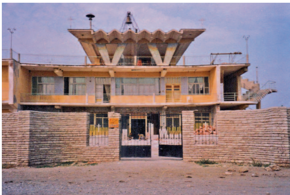
Ricostruzione del Palazzo della Cultura
