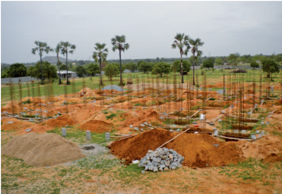
Nalgonda – Costruzione di una casa di accoglienza per bambini in difficoltà
